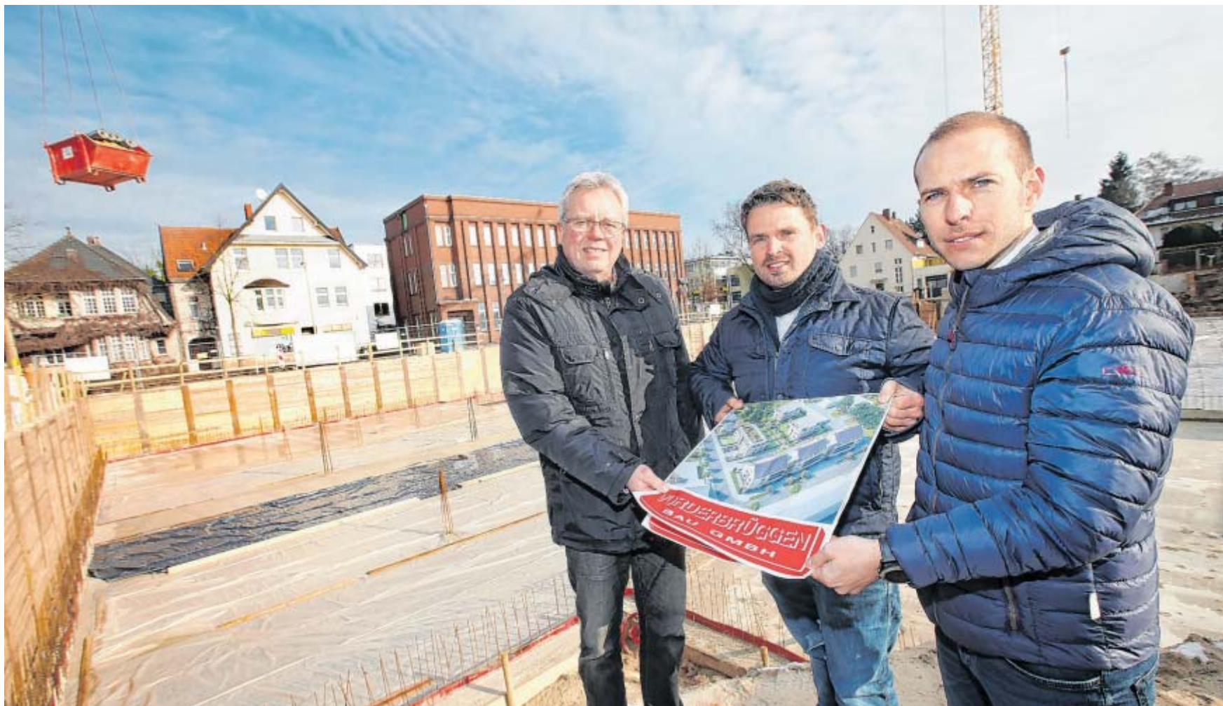
Mit Übersicht: Während im Hintergrund Baumaterial aus der Luft einschwebt, freuen sich Dieter und Christian Vorderbrüggen sowie Bauleiter Benedikt Schneider über den Baufortschritt. Seit zwei Tagen ist die Sohle für die Tiefgarage gegossen. Jetzt geht es aufwärts. FOTO: PATRICK MENZEL
